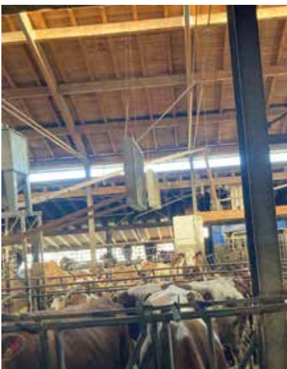
Häufig sind wie in diesem Fall die Lüfter zu hoch montiert und nicht geneigt. Das bringt zwar Frischluft, jedoch keine Kühlung der Tiere
