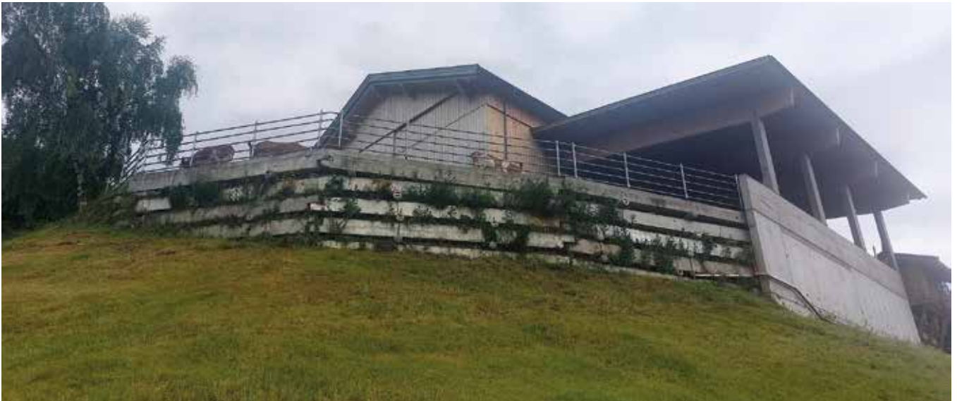
Der Auslauf mit seinen bis zu sieben Meter hohen Stützmauern wurde im extremen Steilgebiet gebaut
